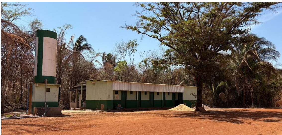
Depósito de Químicos
